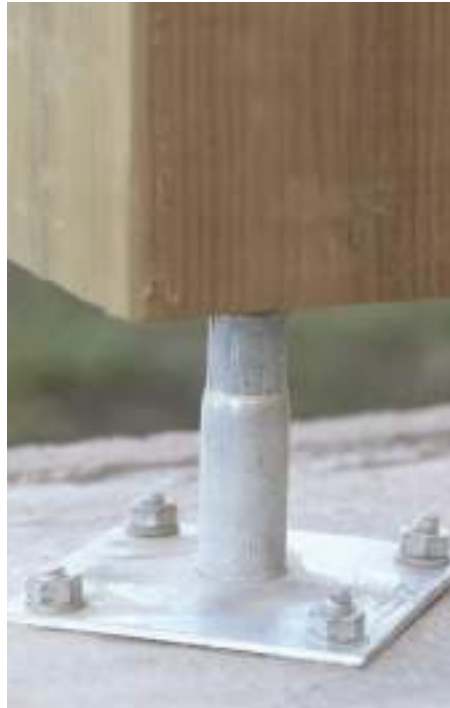
PIEDS DE POTEAU
